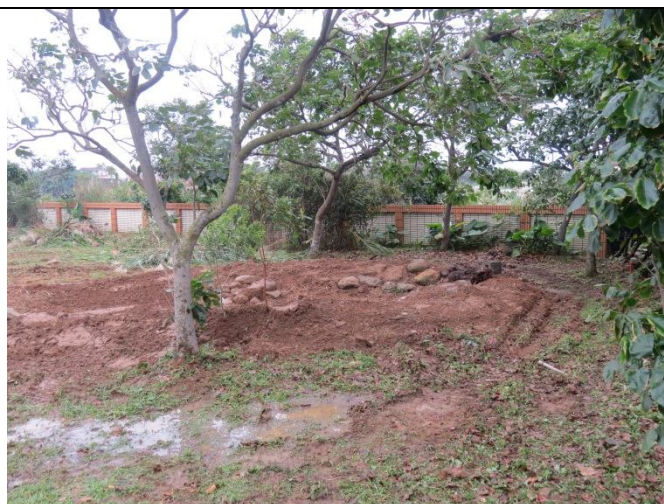
校園生態池施工
