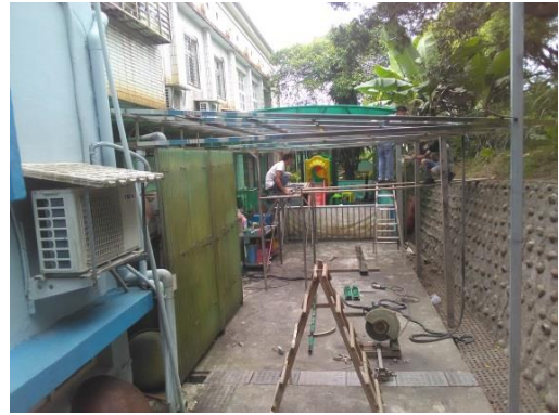
戶外遮雨設施設置中
