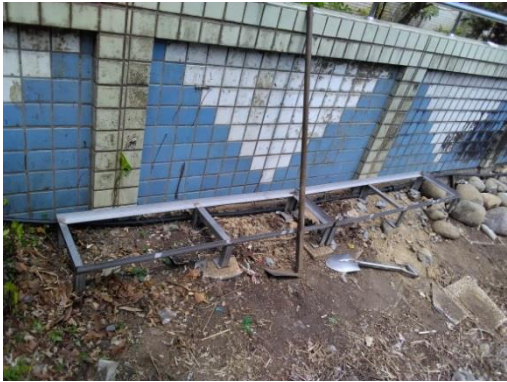
生廚餘堆肥區清理
