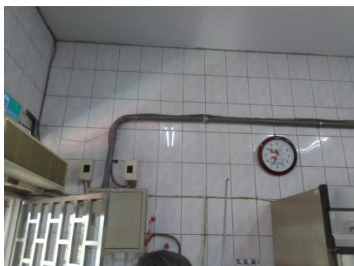
廚餘處理機配電設置
