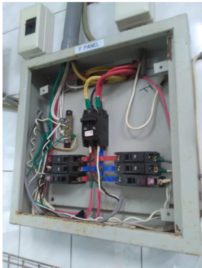
廚餘處理機配電施作
