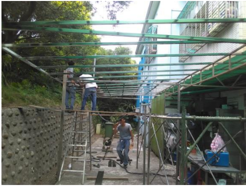
戶外遮雨設施設置中
